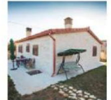
Fachada ferrada en piedra
